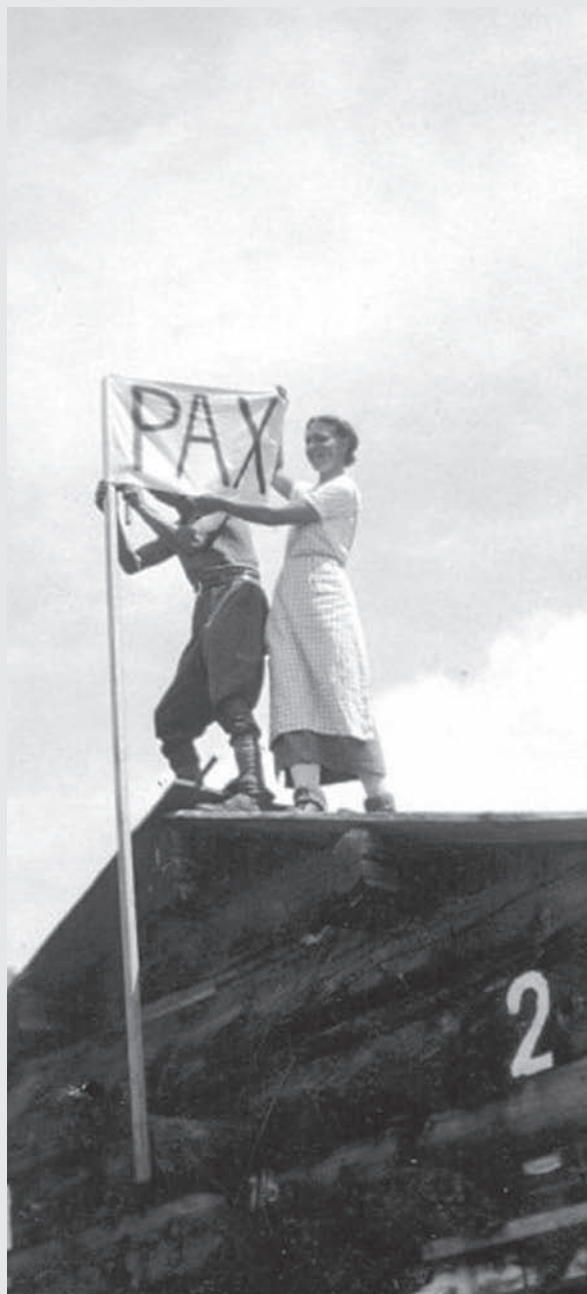
Chantier à Lötschental (Suisse), 1937 (SCI)
