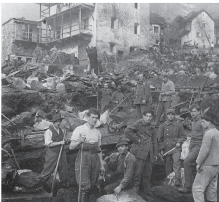
Chantier de Someo (Suisse), 1924 (SCI)
