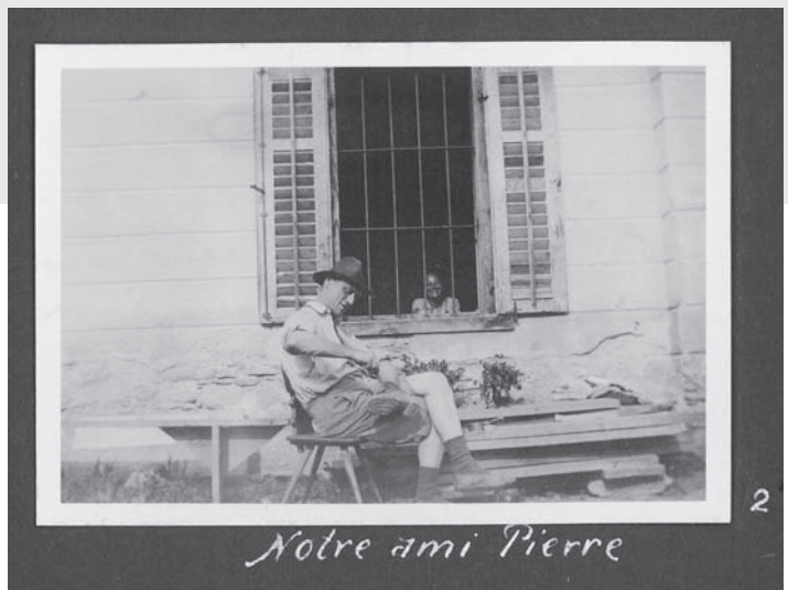
Chantier d'Almens, 1926 (SCI)
